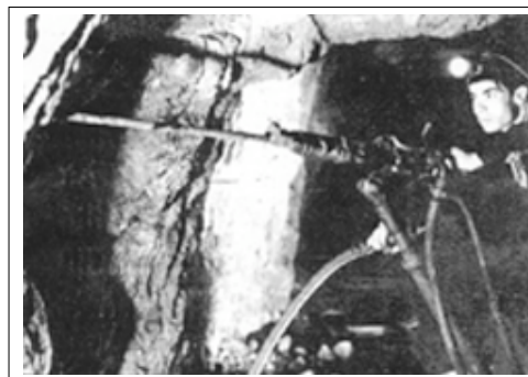
Fig. 9 - Desmonte por martelo pneumático em meados da década de 60 do séc. XX.
